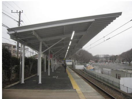
こどもの国駅ホーム屋根現地写真
