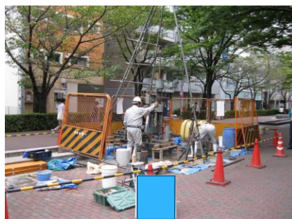
写真-1.ボーリング調査
