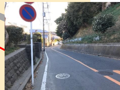
→車線の区分はあるものの歩道がない道路を走行する。
