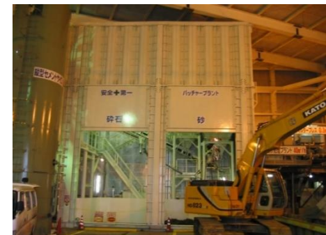
コンクリートプラントエリア(イメージ)
