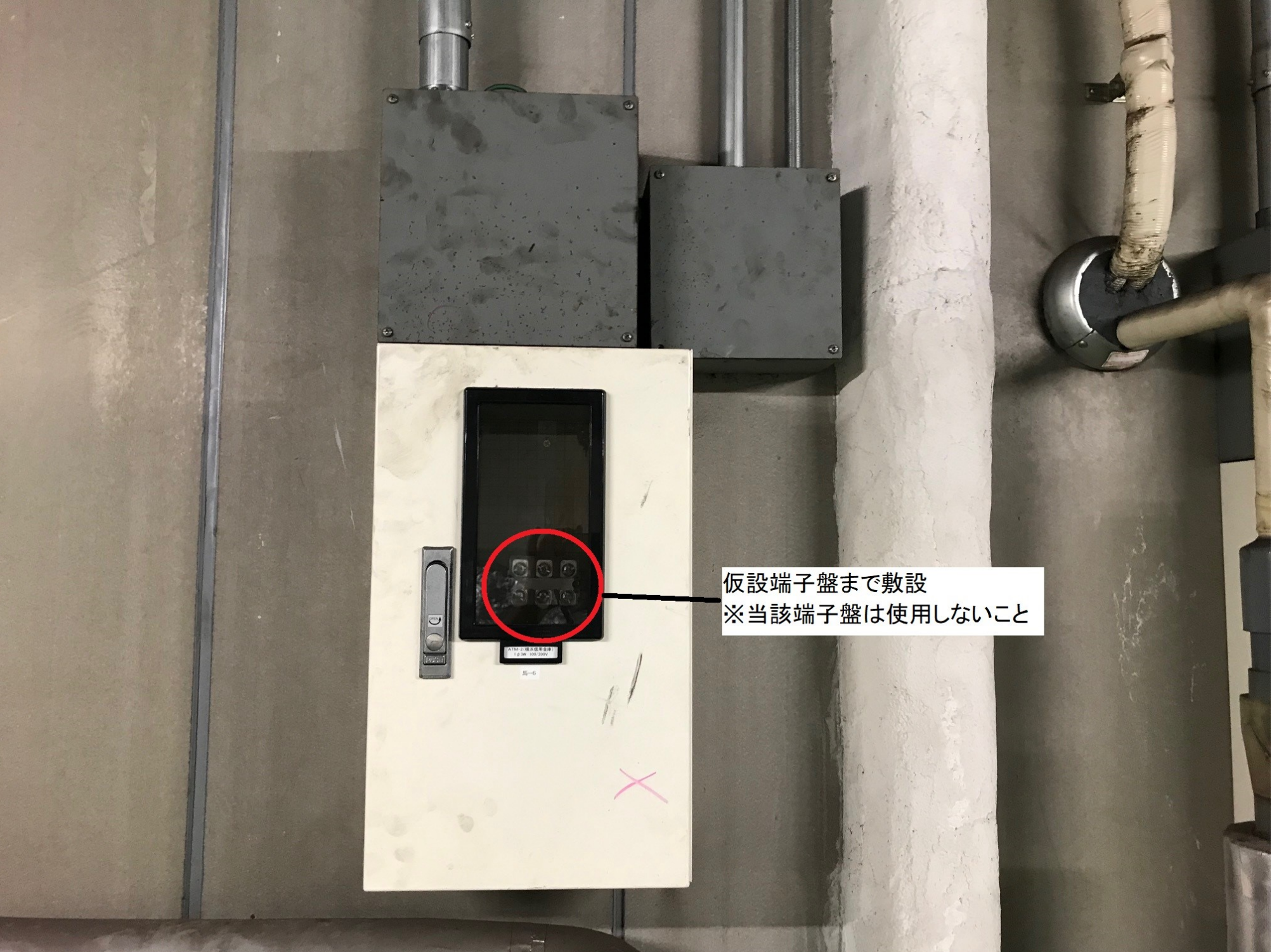
設置予定地壁面裏電源ケーブル敷設状況
