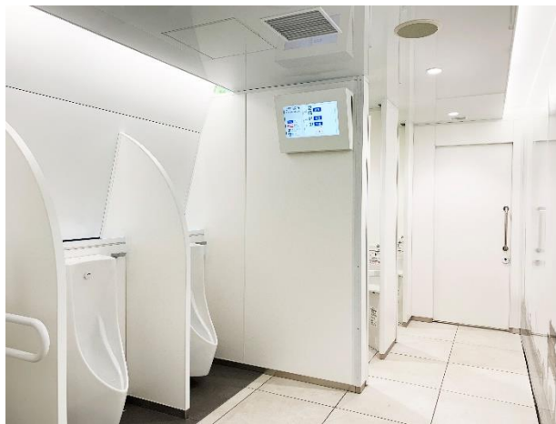
在室表示モニターによる空き状況の確認
