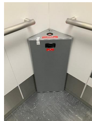
エレベーター防災キャビネット
