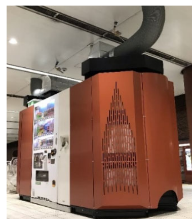
列車の走行風を利用した涼房設備（クールゲートシステム）
