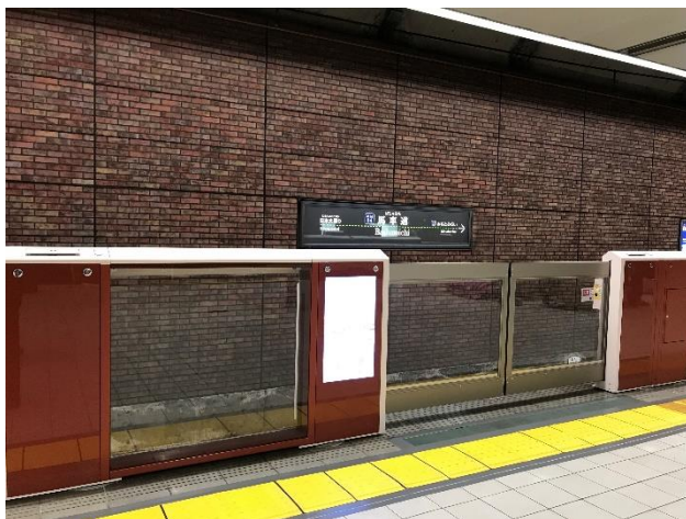
馬車道駅可動式ホーム柵
