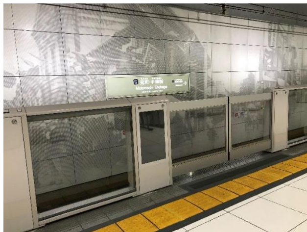
元町・中華街駅可動式ホーム柵
